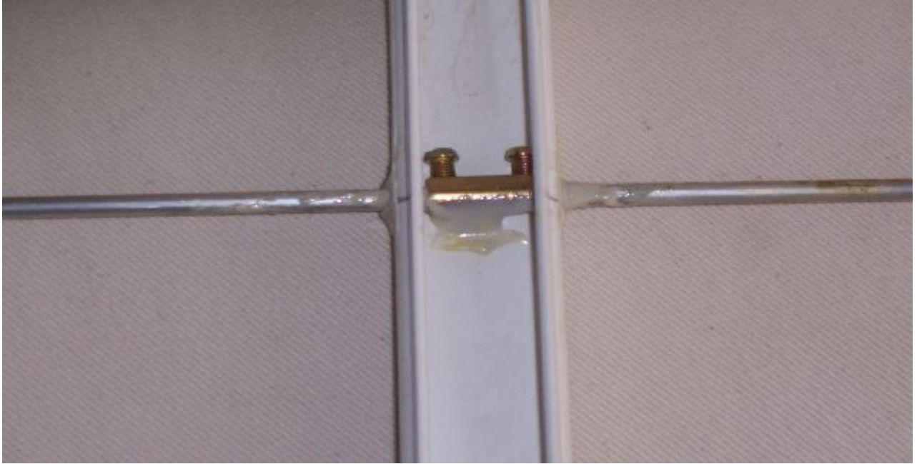
Figura 3: Uno de los elementos 3 pasivos. Las fichas de empalme se le han quitado el plástico de recubrimiento y se han volcado hacia un lado, para poder cerrar la tapa de la canaleta. Las varillas y fichas se sellan con pegamento.
